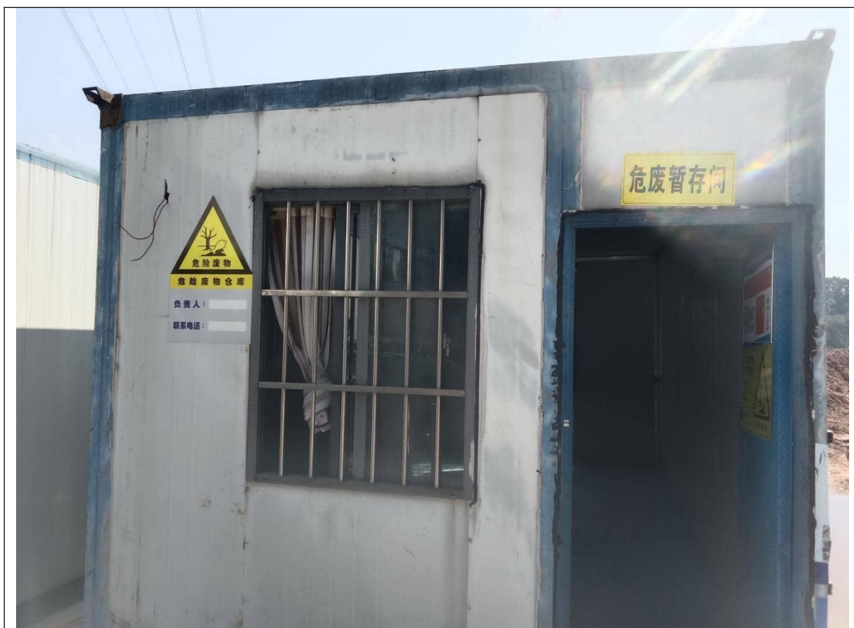
图 3-2 危废暂存间现场照片
