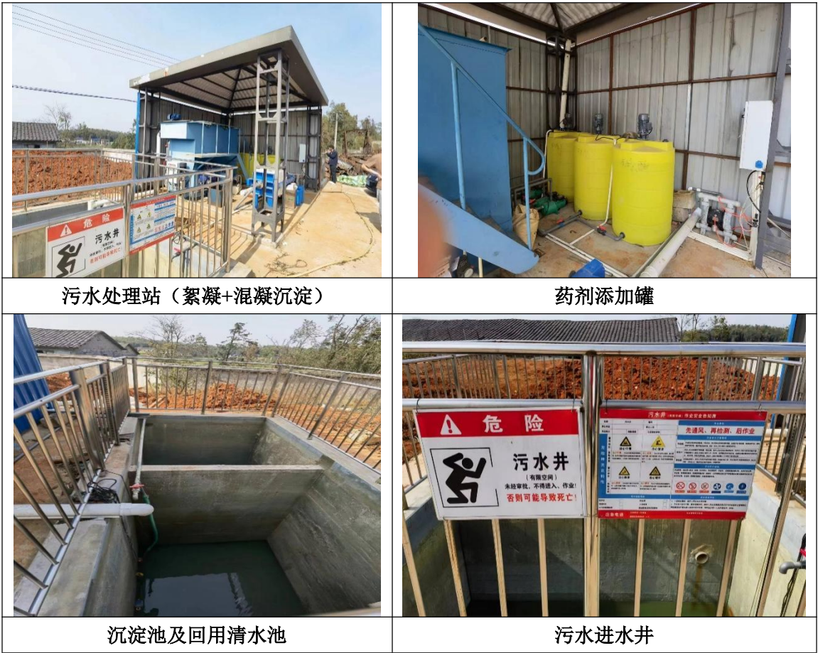
图 3-1 污水处理设施现场照片
