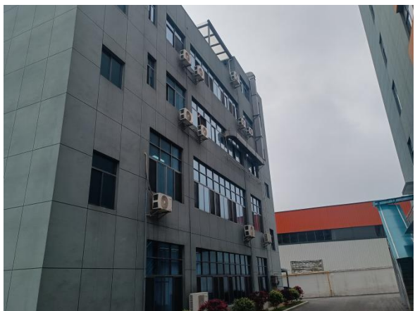
食堂油烟排气筒
